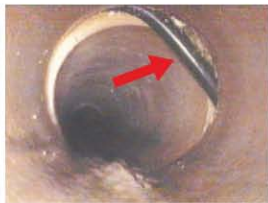
einragende Dichtung
