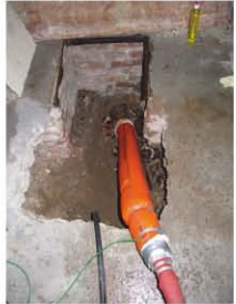
Aushärten des Liners
