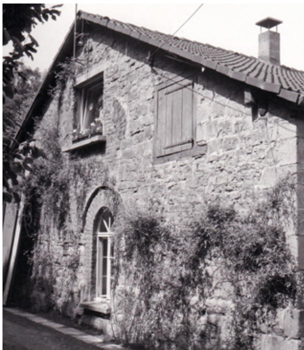
(20) Ehemaliges Schachtgebäude des Schachtes Sack (Gustav-Adolf Wüstenfeld 1983)
