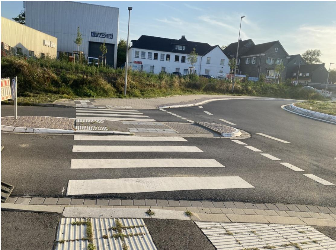
Abbildung 4-9: Querungsstelle am Kreisverkehrsplatz Hauptstraße / L70n, Niedersprockhövel mit differenziertem Doppelbord (Foto: VIA eG)
